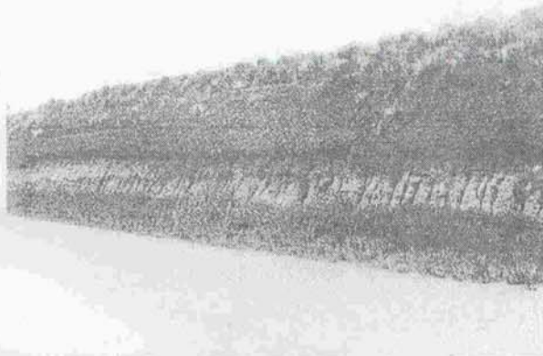
Foto 2 - A freqüente limonitização da superfície que desenvolve excelente proteção de talude: quando e quão naturalmente? Como produzir artificialmente?
