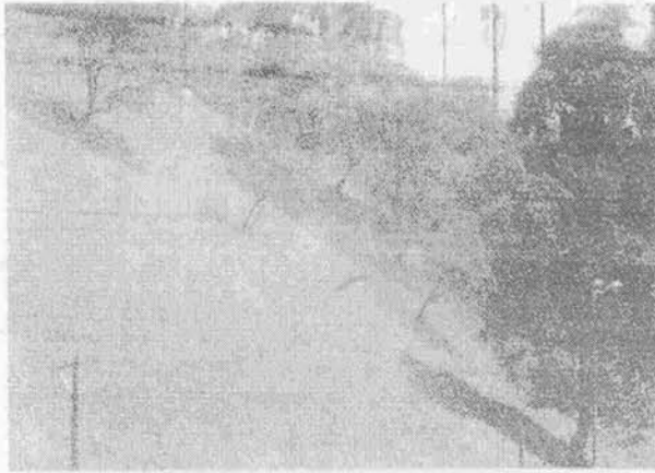
Foto 1 - Evidência freqüente, perigosa em área urbana. As árvores são inclinômetros estatisticamente válidos para nossos perfis de solos que melhoram muito com a profundidade? Qual o limiar do risco?
