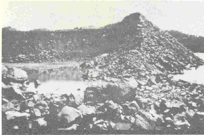
Fig. 23 — Um exemplo de comparação de taludes de estoque de enrocamento
