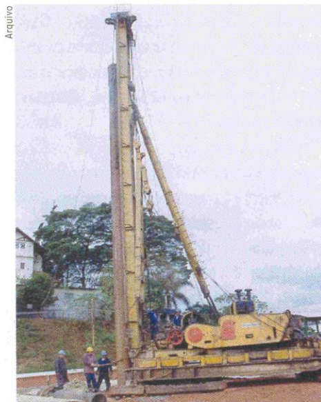
Estacas pré-fabricadas prevalecem hoje nas fundações
